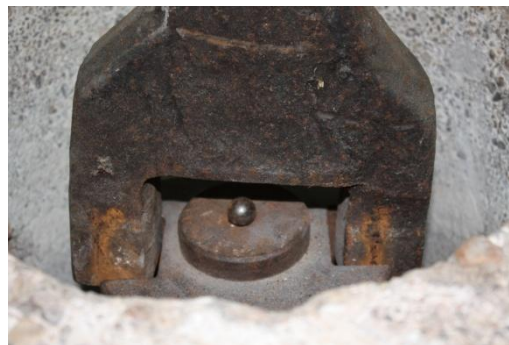
Figuur 6 De vork van het staak van het linker steenspil met slijtplekken
