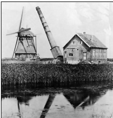
Sloop van de schoorsteen van het stoomgemaal in 1935
