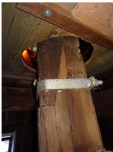
Het koningsspil uit twee delen met stroppen
